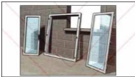
شکل ۷۱ باز کردن قسمت‌های بازشو برای نصب قاب پنجره
